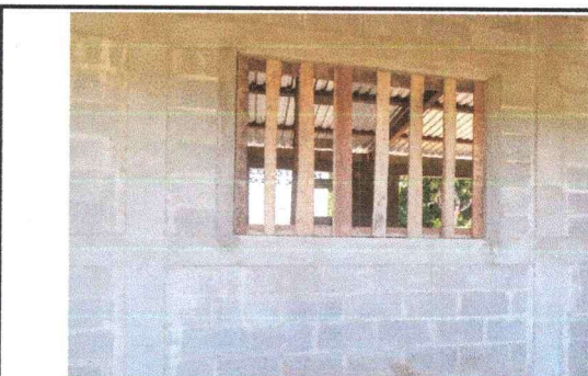
Foto 6: Sustitución de 8 ventanas de madera por balcones de metal en dos aulas. Pintura en muro interior y exterior.
