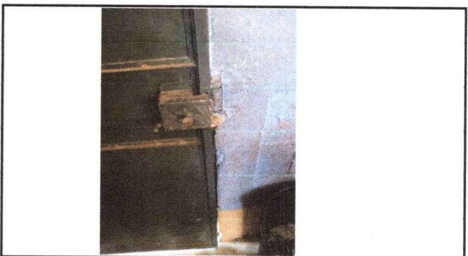
Foto 4: Mantenimiento de puertas y cambiode 4 chapas.
