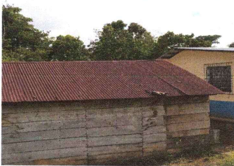
Foto 5: Sustitución de cubierta de láminas, con necesidad de mantenimiento.
