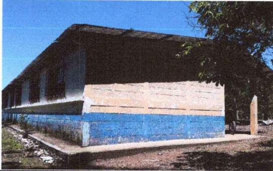
Foto 1: Vista de la infraestructura del edificio escolar actual.
