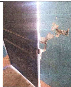
Foto 4: Mantenimiento de puertas, cambio de chapa y de pared agrietada.
