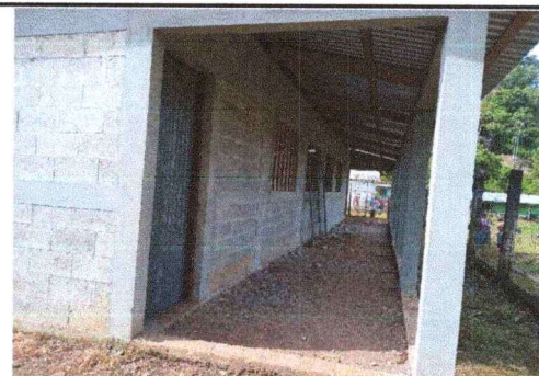
Foto 6: Aulas con piso de tierra necesidad de mantenimiento correctivo.
