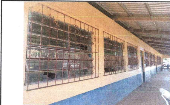
Foto 3: Vista exterior del edificio escolar que requiere servicio de mantenimiento, reparación en ventana, pintada de balcones y pared. (frente del establecimiento)
