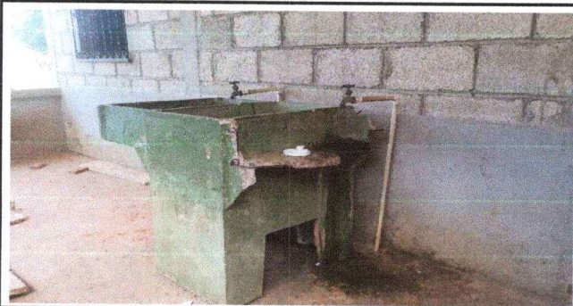
Foto 5: Sustitución de una pila para la cocina del establecimiento educativo y pintura exterior e interior.
