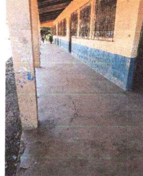
Foto 2: Vista actual del corredor del edificio escolar.
